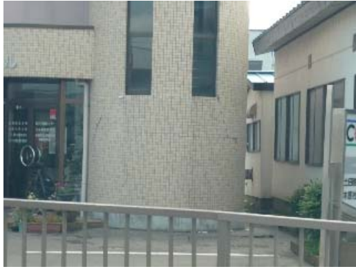
写真 8.37 外階段の外壁タイルのひび割れ 写真 8.38 ショーウィンドウのガラスの破損
