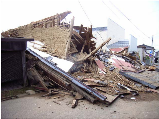
写真 5.15 土壁を有する古い構法の倒壊家屋 写真 5.16 写真 5.15 の建物の部材の腐朽・蟻害
