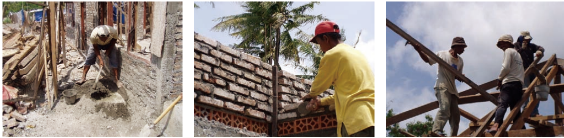
インドネシアにおけるノンエンジニアド住宅の建設の状況
